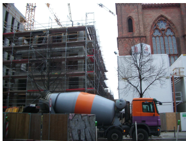
Neubau neben der Friedrichswerderschen Kirche. Foto von Wolfgang Schoele (Austausch des Fotos, das in der NZZ veröffentlicht wurde)
