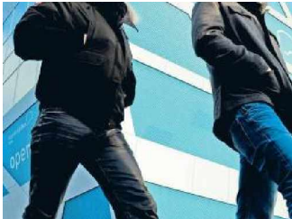
Berlins temporäre Mitte. 28 Meter ist die Box (r.) hoch, fünf Etagen befinden sich darin – ganz oben das Café mit Blick auf Dom und Baustelle. Die Box bleibt bestehen bis zur Schlosseröffnung, theoretisch bis 2010 (Foto: Doris Spiekermann-Klaas)...
