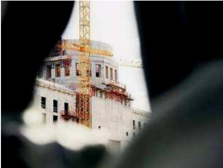
Wo bald die Musen wohnen. Blick auf den Rohbau von Franco Stellas Schloss-Replik, in die 2019 das Humboldt-Forum einziehen soll.
